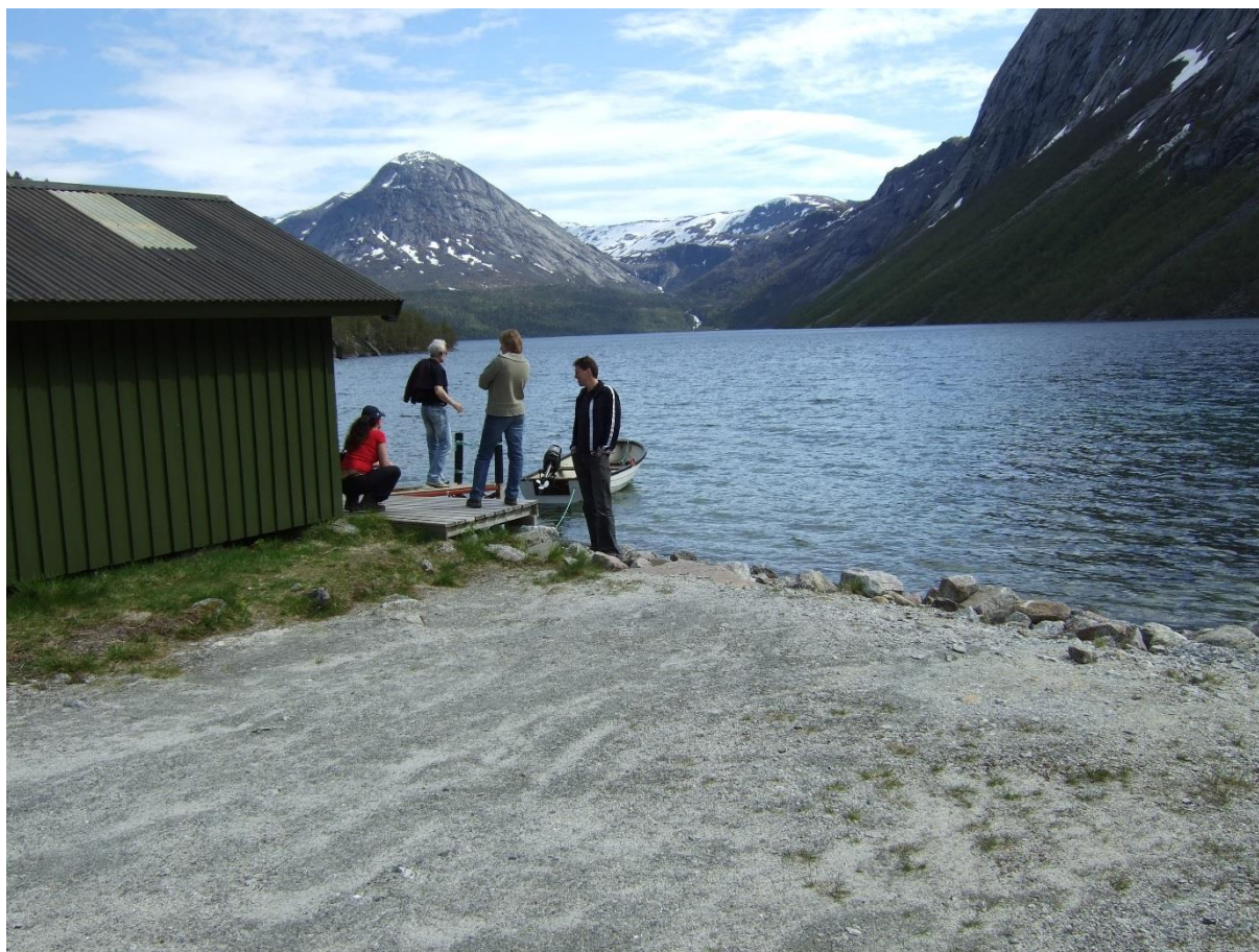
Figur 11 Sildhopen vannverk, Sildhopvatnet
