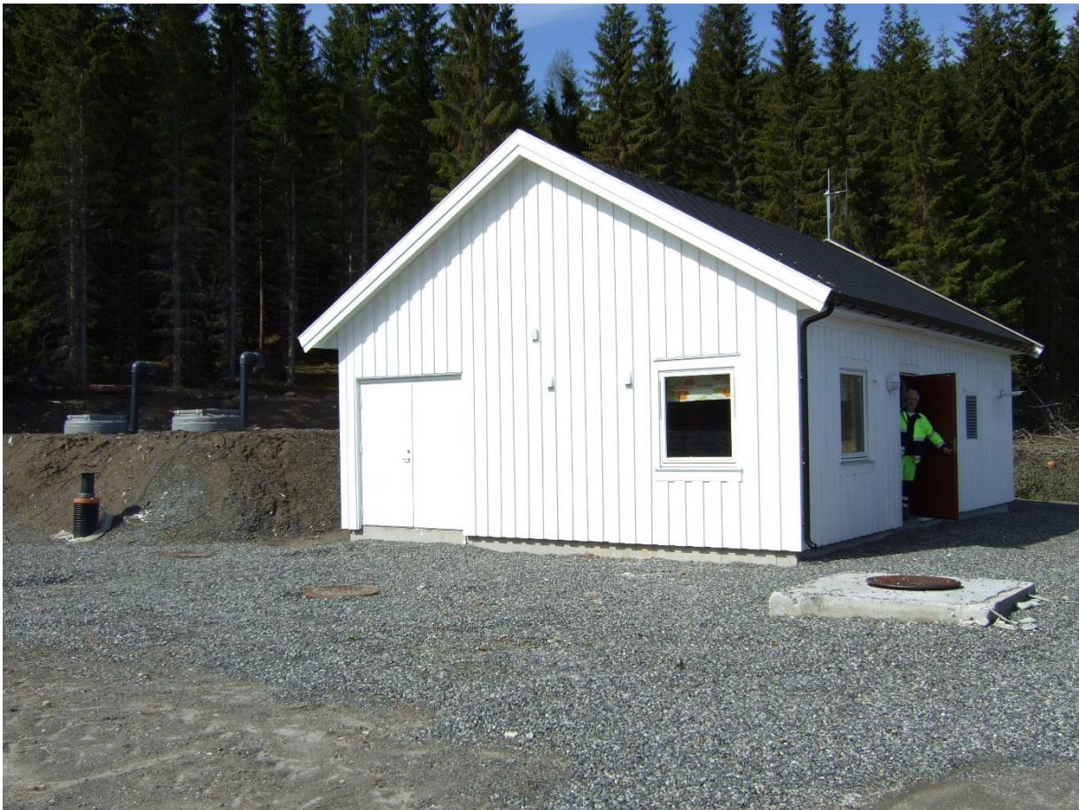
Figur 3 Røsvik vannverk – Vannbehandlingsanlegget
