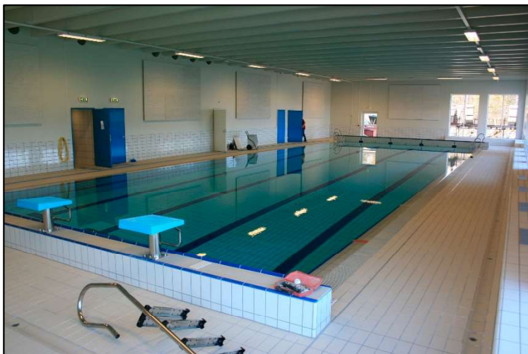
I mai 2022 ble det gjennomført tilsyn ved bassenget i Sørfoldhallen. Foto: Kåre Isaksen
