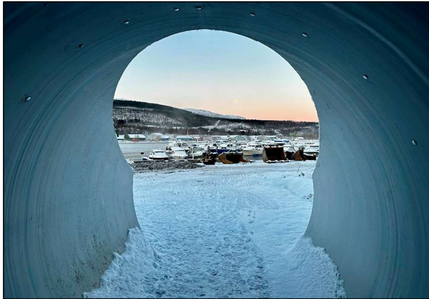
Kulvert under E6 i forbindelse med ny gang – og sykkelvei. Foto: Bente Braaten.
